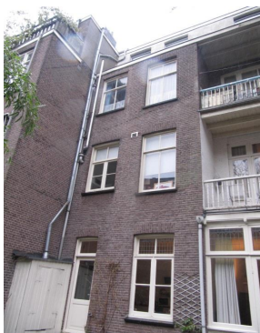
Foto 2: Overzicht ged. achtergevel
