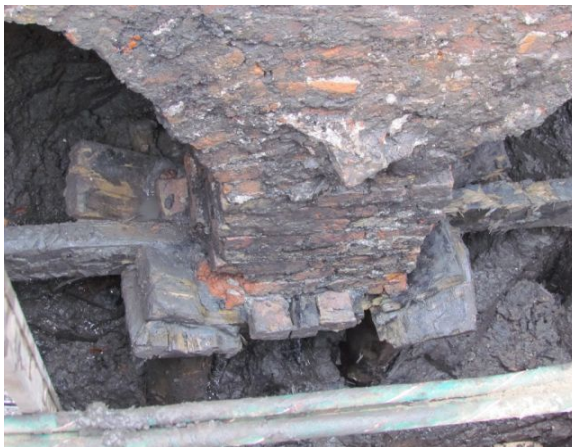
Ingezoomde foto inspectieput van bovenaf
