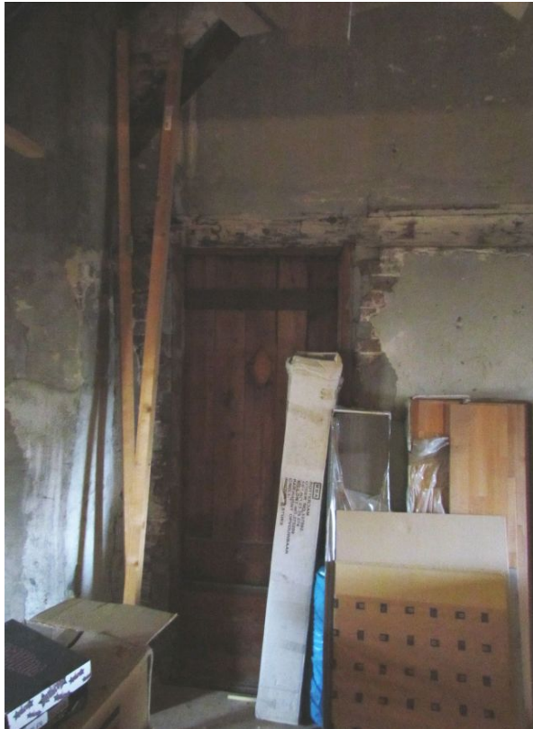
Branddeur zolderverdieping tussen 36 en 38.
