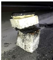
Afb 33. Aanzicht opbouw dak.
