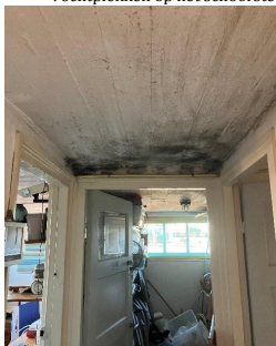
Schimmelvorming op het plafond in de hal en de naastgelegen berging
