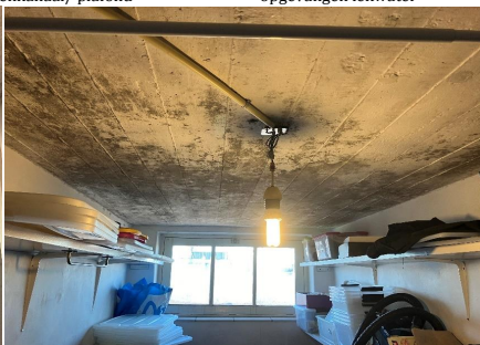
Schimmelvorming op het plafond in de hal en de naastgelegen berging
